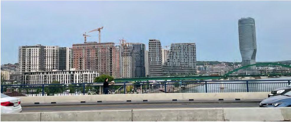
Abb. 4 Blick auf das im Bau befindliche BW (Quelle: Aufnahme d. A., Mai 2022)
