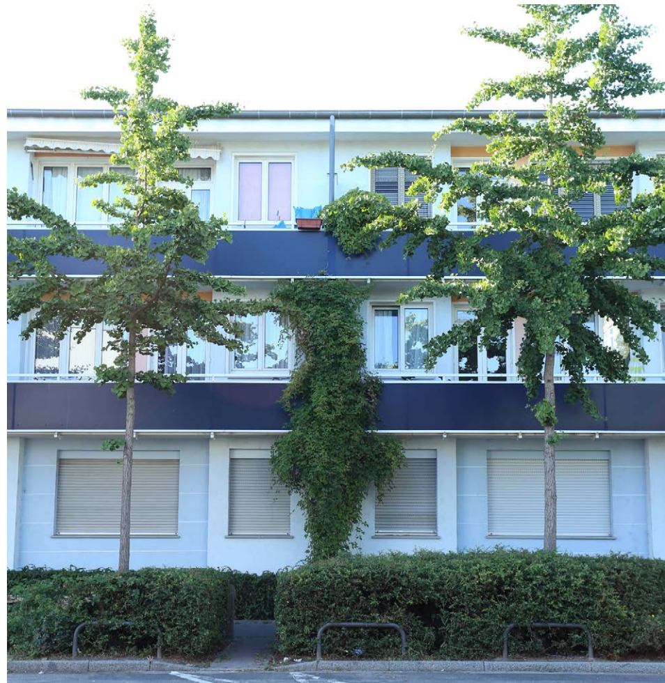
Abb. 12 Einfache Wohnungen in der Hellerhofsiedlung, Idsteiner Straße, Aug. 2014 (Foto: David Schommer)
