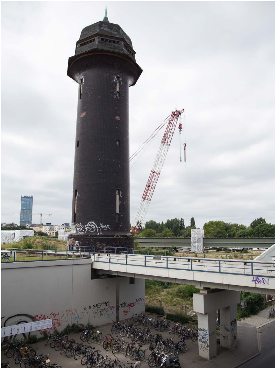
Abb. 1 Großbaustelle Bahnhof Ostkreuz, Gleisanlagen und Wasserturm (Foto: Anna Blattner)
