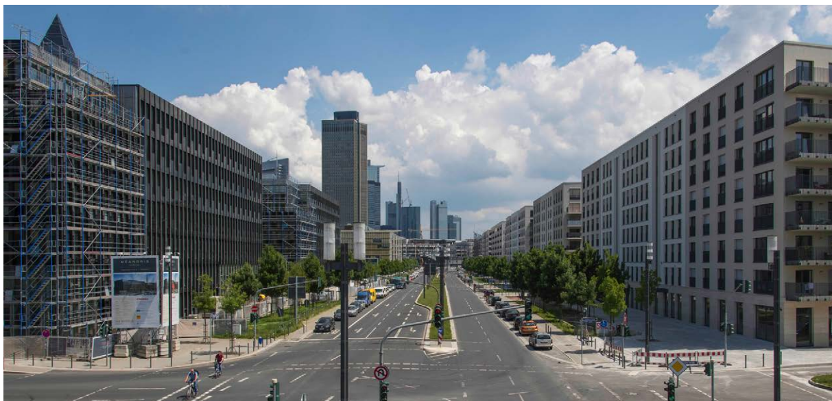
Abb. 6 Blick von der Emser Brücke auf das östliche Europaviertel und die Europa-Allee, Juni 2013 (Foto: CC Epizentrum)
