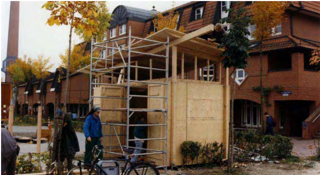
Abb. 5 Bau der Fahrradwerkstatt 1996 (Quelle: Archiv Fahrradwerkstatt des AStA Kassel)
