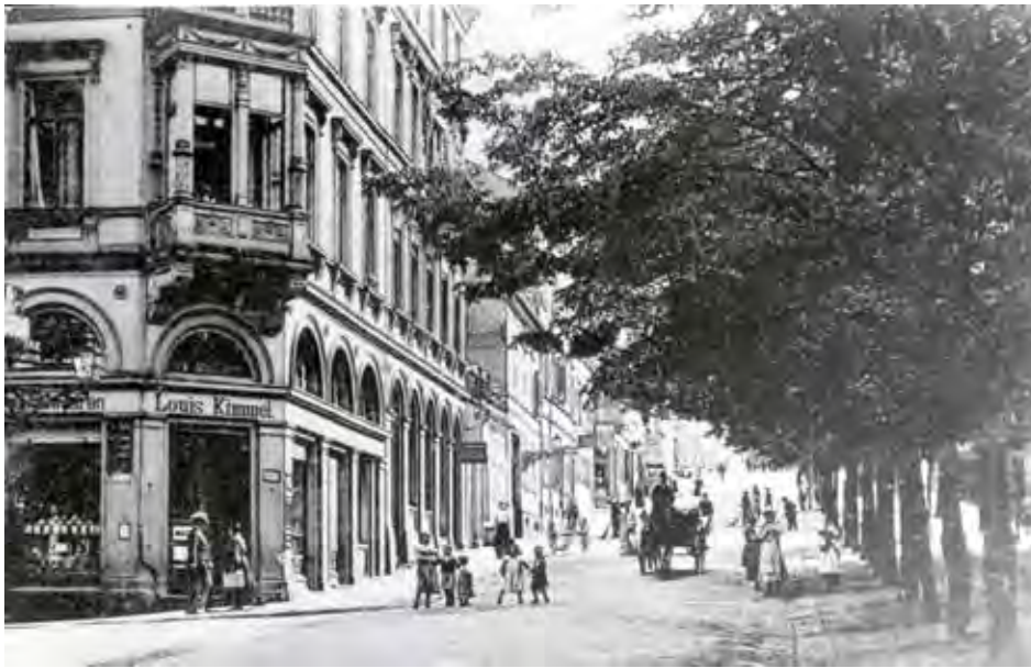
Abb. 1 Röderallee, unterer Abschnitt, um 1910 (Quelle: Sammlung Foto Rudolph, Wiesbaden)
