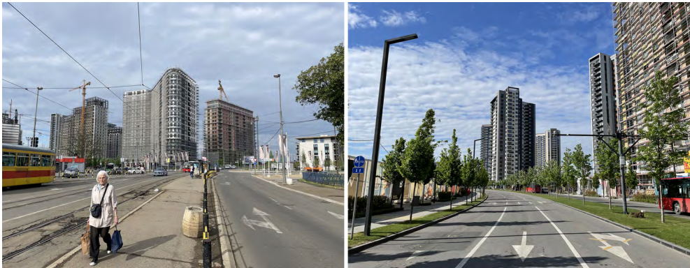
Abb. 5 BW in der Umsetzung. Links: Blick von der Innenstadt aus. Rechts: Hauptstraße des neuen Viertels (Quelle: Aufnahmen d. A., Mai 2022)
